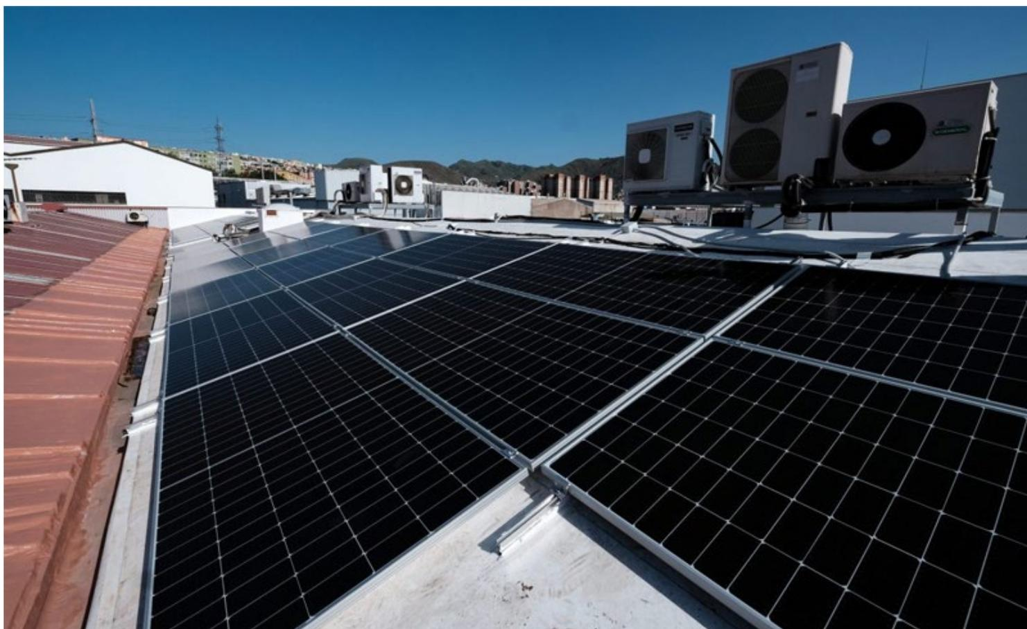
La instalación se compone de 75 módulos fotovoltaicos de 540 kW, capaces de producir 68.619,74 kWh anuales de energía renovable.
